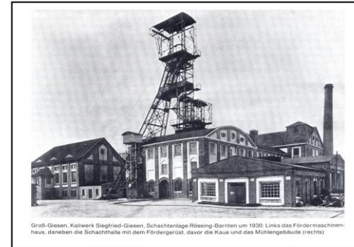
Groß-Giesen, Kaliwerk Siegfried-Giesen, Schachanlage Rössing-Barnten um 1930. Links das Fördermaschinenhaus, daneben die Schachthalle mit dem Fördergerüst, davor die Kasse und das Mühlengebäude (rechts)
